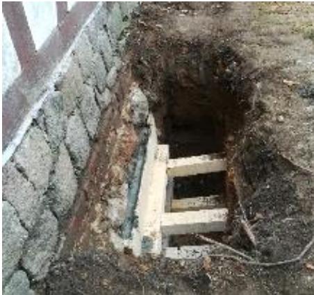
Abbildung 5: Vertiefung des Fundaments des Vorbaus
