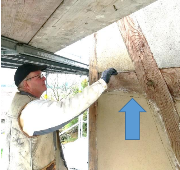
Abbildung 3: Erzeugen des umlaufenden „Kellenschnittes“ bei frisch verputzten Gefachen
