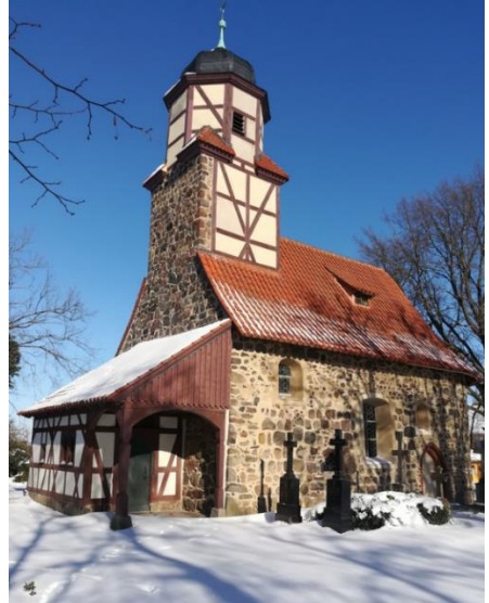
Abbildung 7: Kirche nach Abschluss der Arbeiten an Hülle, Turm und Vorbau
