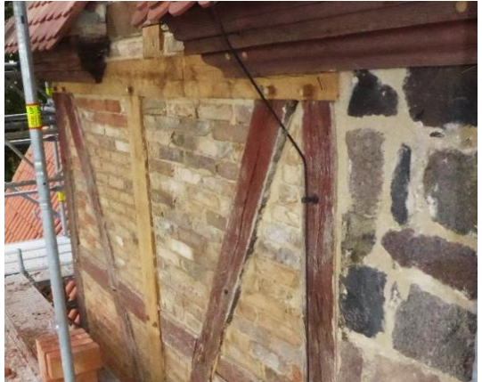
Abbildung 3: Saniertes Teil des Turmfachwerkes (noch ohne Putz)
